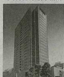
⑨ 武蔵小杉駅前事務所
