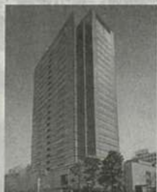
⑨ 武蔵小杉駅前事務所
