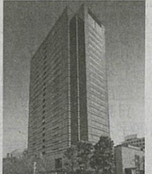
⑨武蔵小杉駅前事務所
