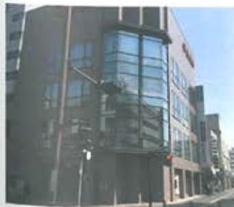
湘南台駅前事務所(外観)
